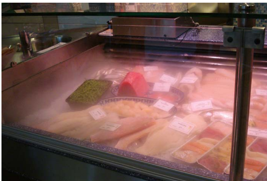
Figur 2. Nederlandsk fiskedisk med tilleggskjøling v.h.a. vandusj.
